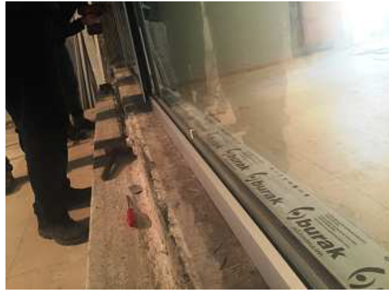
Numune Etrafı Yalıtım Çalışmaları
