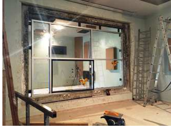
Numune Etrafı Yalıtım Çalışmaları
