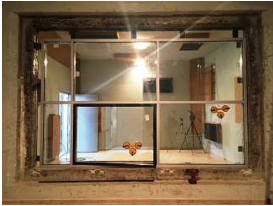
Numune Etrafı Yalıtım Çalışmaları
