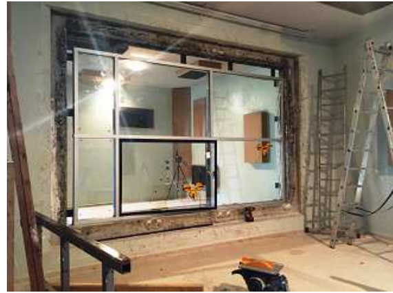
Numune Etrafı Yalıtım Çalışmaları
