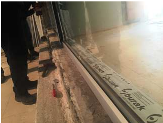
Numune Etrafı Yalıtım Çalışmaları
